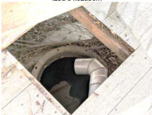
Nádrž na dažďovú vodu
